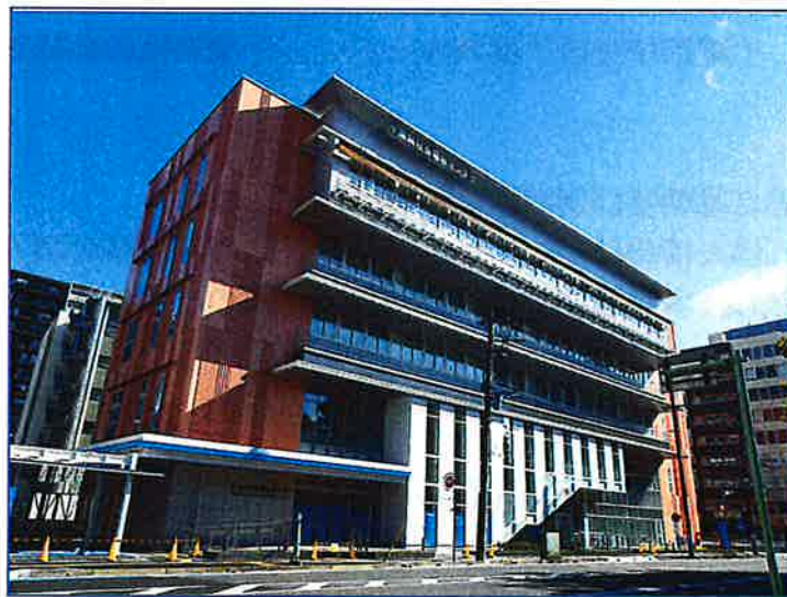
令和5年4月にオープンした千葉県社会福祉センターの外観
